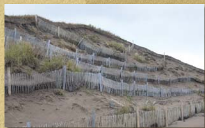
Pose de ganivelles dans les dunes. Photo CELRL.
