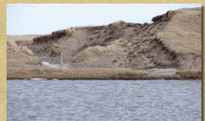
Erosion des Butterreaux - Mars 2007. Photo B.Letournel.
