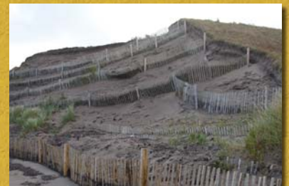
Travaux de restauration des dunes. Photo CELRL.
